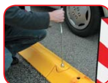
Za dulje periode korištenja delineatori se mogu učvrstiti vijcima
