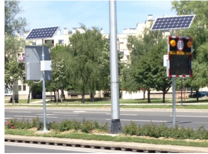
Zagrebačka Avenije, Zagreb postava na središnjem zelenom pojasu po jedan uređaj za svaki smjer
